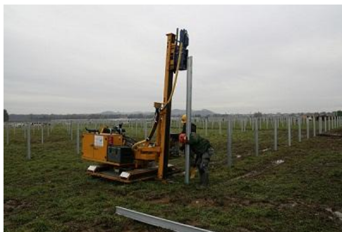
Fot. 15. Wbijanie konstrukcji wsporczych ogniw fotowoltaicznych
