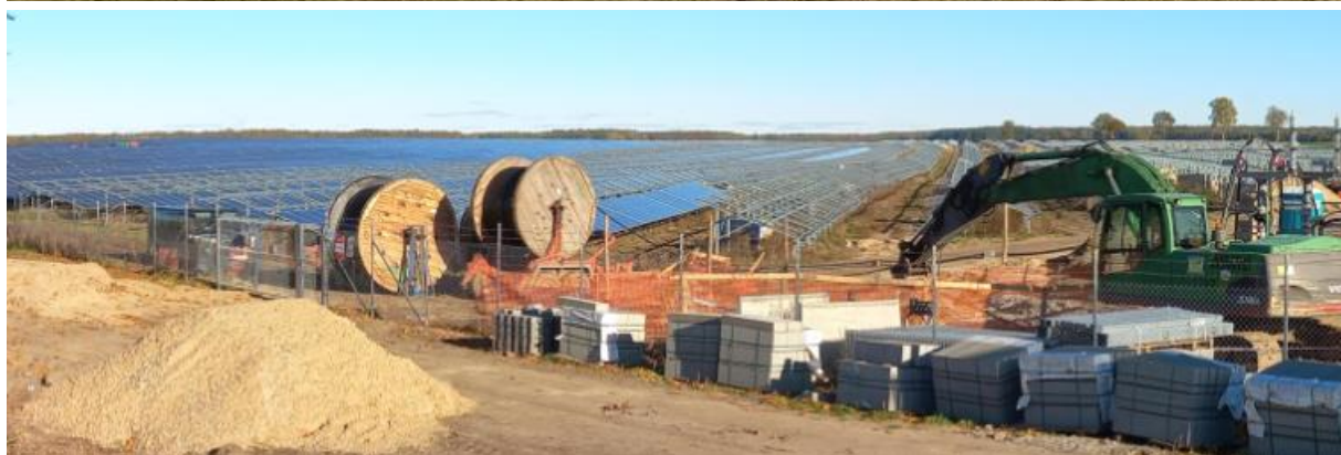
Fot. 7-9. Stalowe konstrukcje paneli fotowoltaicznych na etapie budowy
