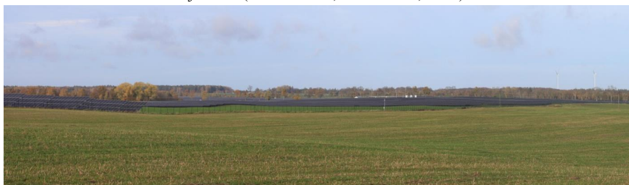
Fot. 12. Widok dużej farmy fotowoltaicznej z odległości kilkuset metrów na terenie falistym (farma fotowoltaiczna koło Zwartowa w woj. pomorskim – fot. M. Przewoźniak)
