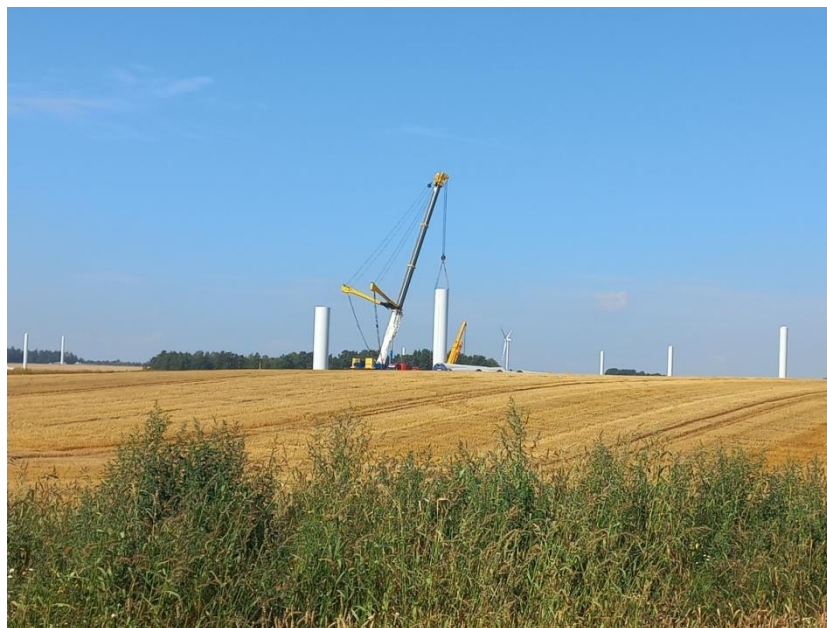
Fot. 4. Zespół elektrowni wiatrowych na etapie budowy.
